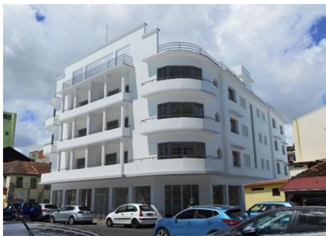
Immeuble La Nationale, après travaux Crédits : Architecte Philippe Zaffran
