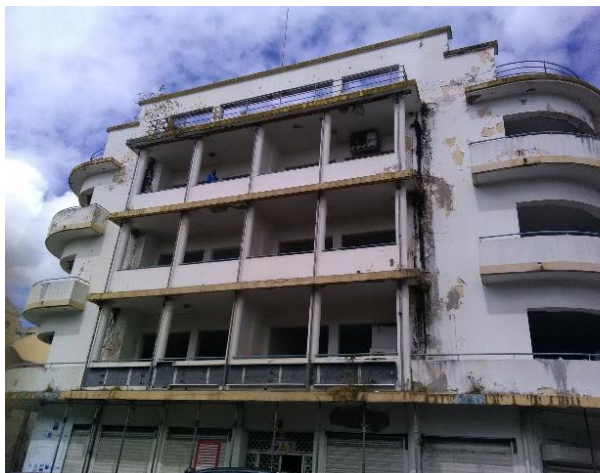
Immeuble La Nationale, avant travaux Crédits : ARCAVS
